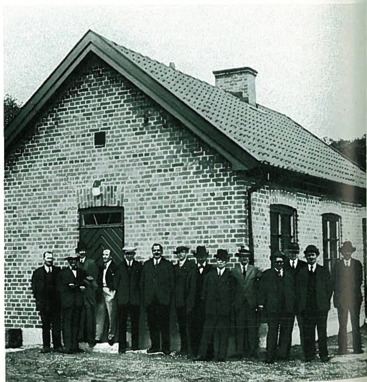
Drätselkammaren tar emot Gunnebobro pumpstation 1932
