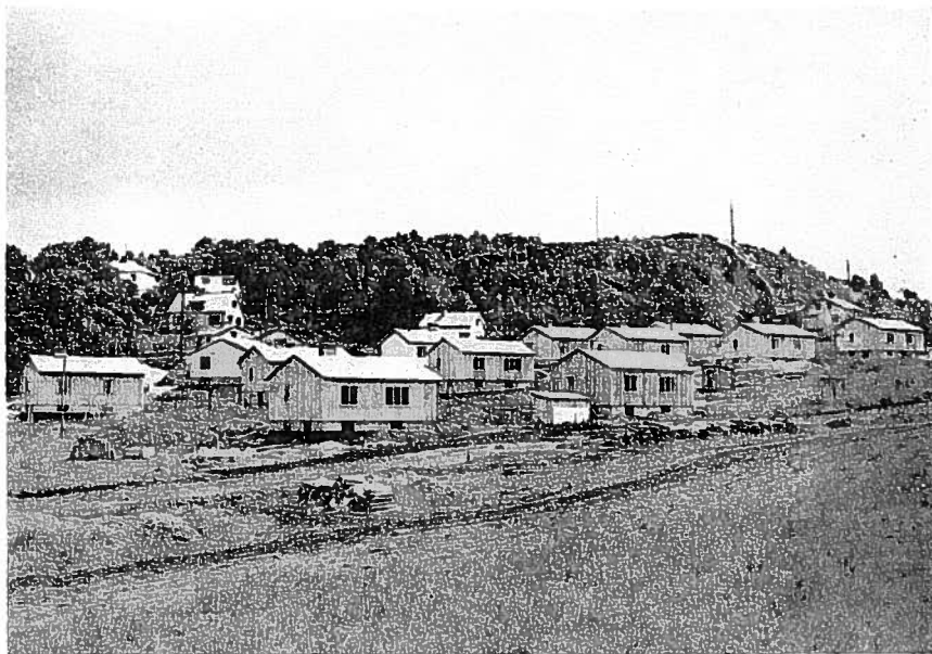
Egnahems-bebyggelsen i Lackarebäck skjuter fart. Gator och ledningar lägges ut.
